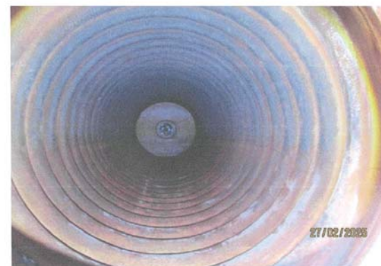
ตรวจสอบสภาพท่อไฟใหญ่ ปกติ
