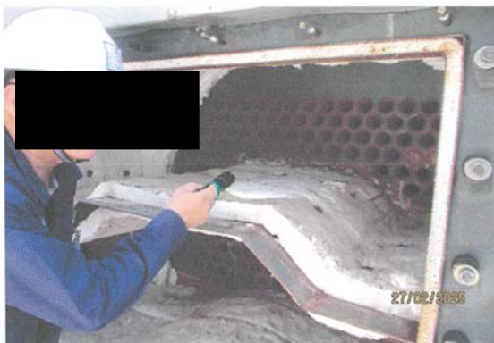
ตรวจสอบท่อไฟเล็กต่างๆเพื่อตรวจสอบการรั่วหลังอัดน้ำที่ความดันที่กำหนด หม้อไอน้ำหมายเลข 5 (Auxiliary Boiler ) บริษัท ราชบุรีเวิลด์ โคเจนเนอเรชั่น จำกัด วันที่ 27 กุมภาพันธ์ 2568
