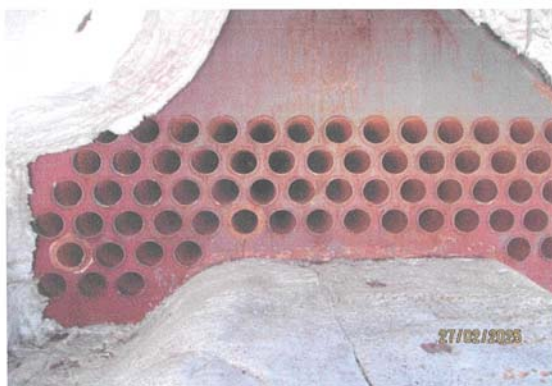
ตรวจสอบสภาพไฟเล็กหลังทำHydrostatic Test ผลปกติไม่มีการรั่วใดๆ หม้อไอน้ำหมายเลข 5 (Auxiliary Boiler ) บริษัท ราชบุรีเวิลด์ โคเจนเนอเรชั่น จำกัด วันที่ 27 กุมภาพันธ์ 2568
